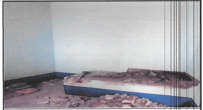
4.Reparación de cocina : sustitucion de estufa rural completa.
