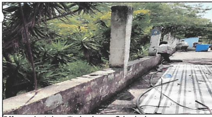
7.Muro perimetral: sustitucion de maya Galvanizada .
