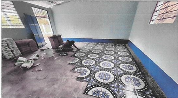
7. Piso sustitución de piso de torta por piso cerámico
