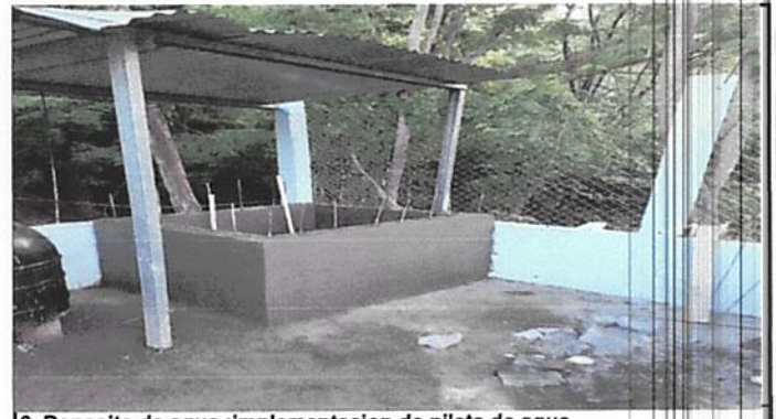
6. Deposito de agua :implementacion de pileta de agua .
